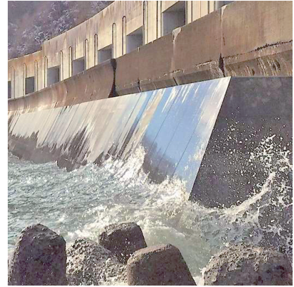
図-11 PFC パネルを用いた補修
