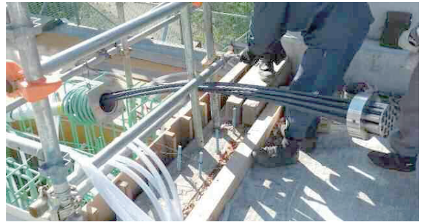
写真-3 ケーブル挿入状況
