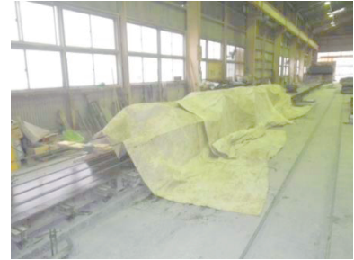
写真-2 蒸気養生状況
