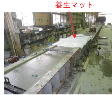
写真-1 打込み面の養生
