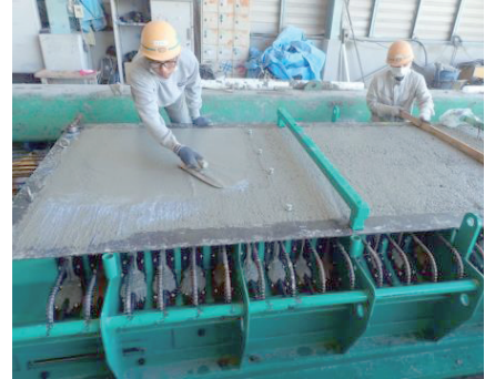
写真-1 打込み状況
