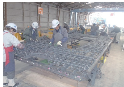
写真-3 鉄筋組立て状況 表-1 開発工程
