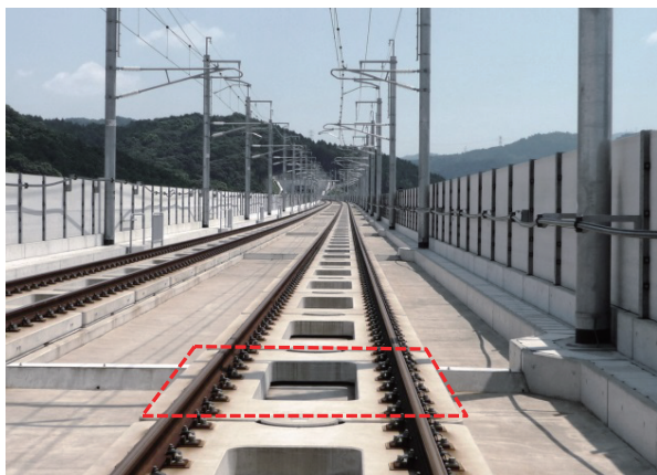
写真-1 敷設された軌道スラブ
