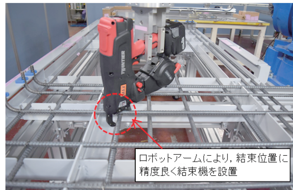
写真-8 結束機設置状況
