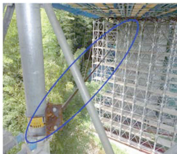
写真-4 PC鋼棒による支柱連結状況
