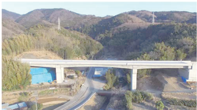
写真-7 完成写真
