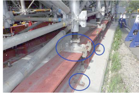
写真-2 支保工ベース部の固定状況
