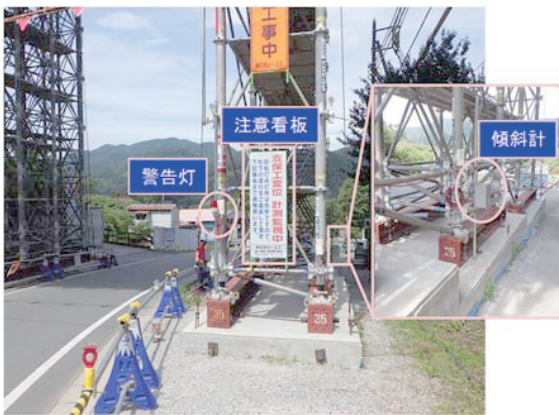
写真-6 傾斜計による監視状況
