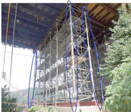
写真-3 支柱の控えワイヤー設置状況
