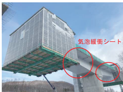
写真-1 仮囲いと気泡緩衝シート
