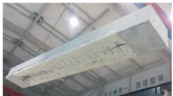
写真-1 加熱試験後の供試体底面
