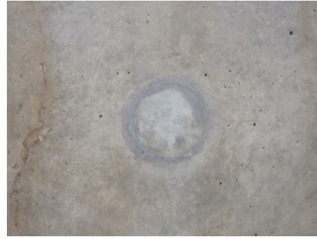
写真-4 Pコン跡処理後
