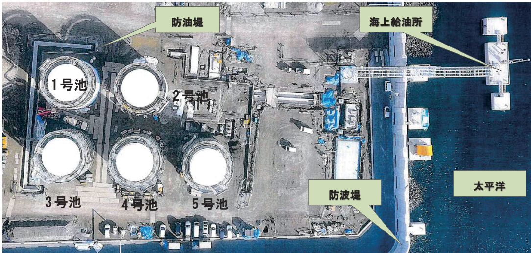
写真-1 施工中写真
