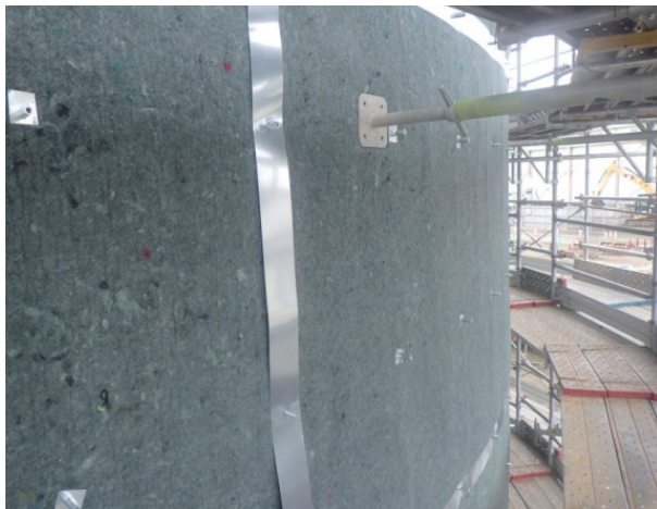
写真-2 繊維シート配置・固定
