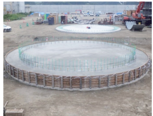
写真-5 基礎版打設完了
