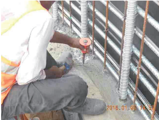
写真-1 チッピングによる打継目処理
