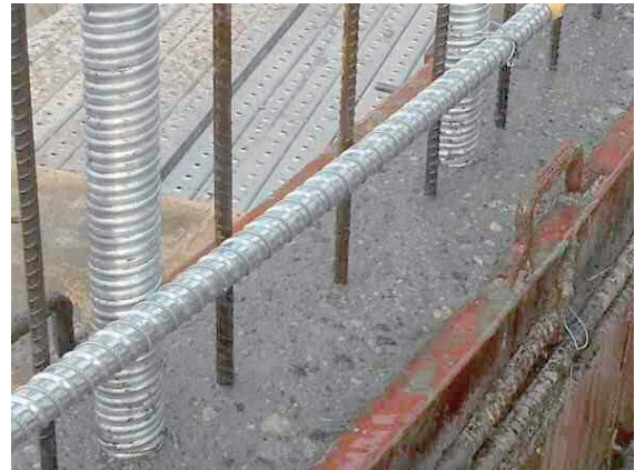
写真-2 遅延剤と高圧洗浄水による打継目処理
