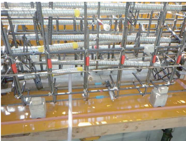
写真-3 ピラスター拡幅部補強筋配置
