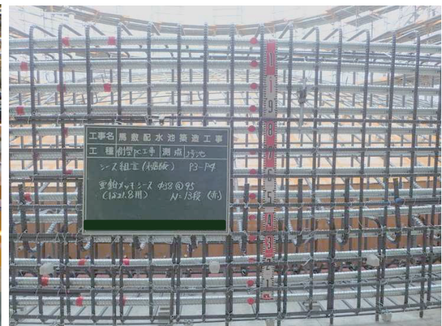
写真-4 水底版ドームリング配置
