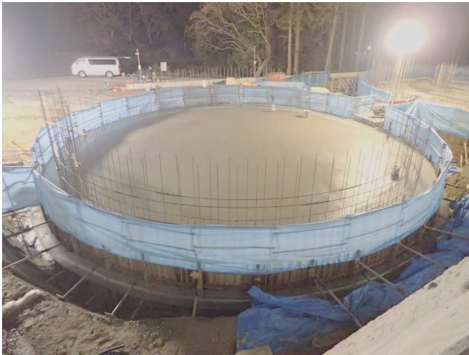
写真-1 シート養生状況
