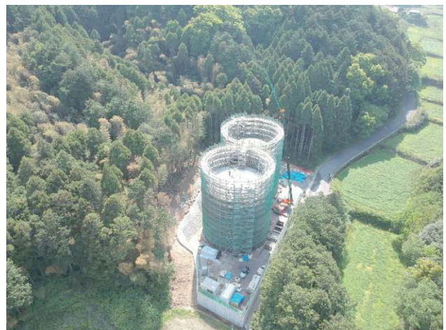
写真-6 ドローンによる現場状況写真
