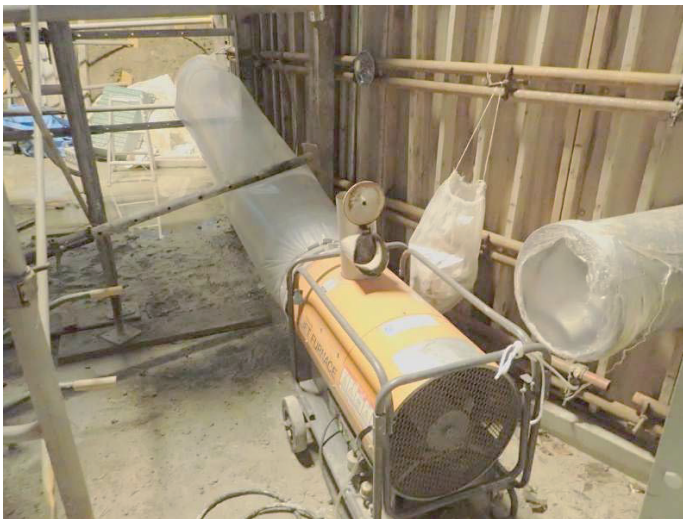
写真-2 ジェットファーンネス養生状況
