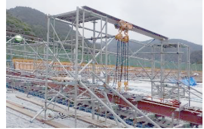
写真-9 伸縮装置架設台
