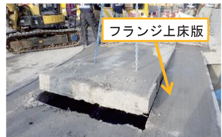
写真-1 既設床版の撤去状況
