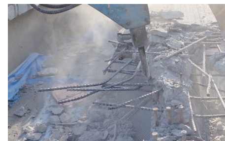
写真-2 フランジ上床版のはつり
