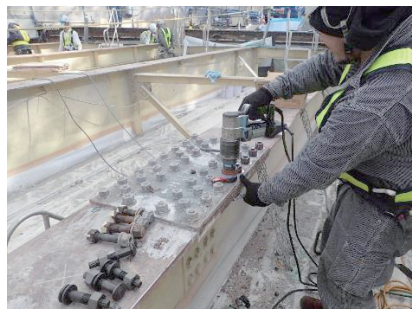
写真-2 ボルト取替え
