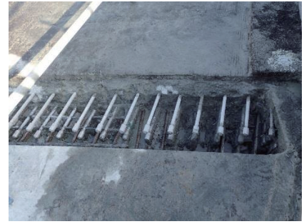
写真-5 接合部はつり後
