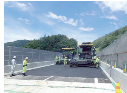
写真-7 舗装施工
