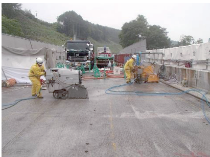
写真-1 床版切断
