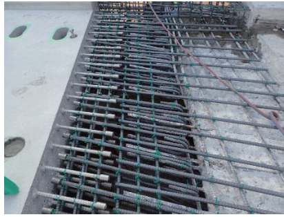
写真-4 接合部鉄筋配置
