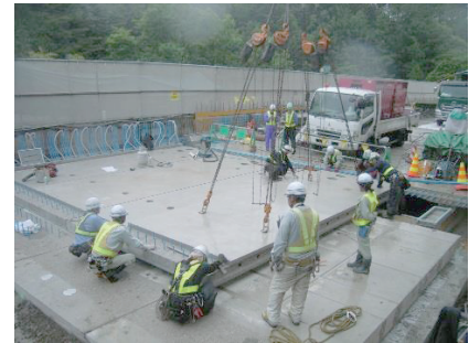
写真-6 延長床版施工
