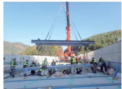
写真-3 PC床版架設
