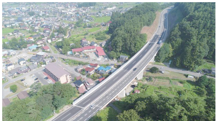
写真-8 完成写真
