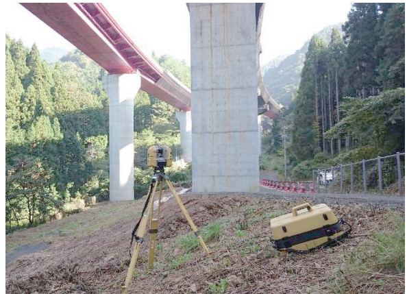
写真-2 3次元計測状況
