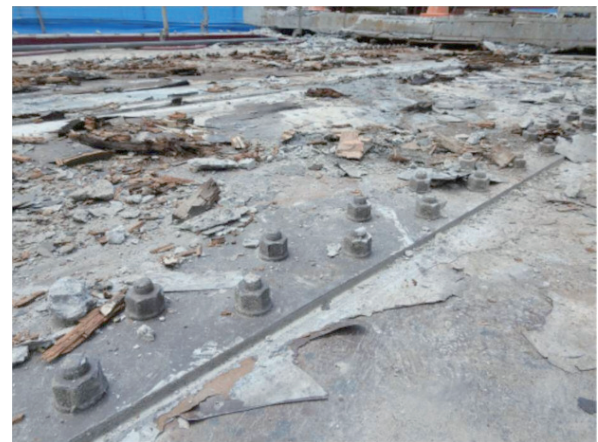
写真-4 鋼箱桁上フランジ (撤去後)
