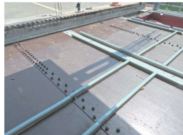
写真-5 素地調整剤塗布後
