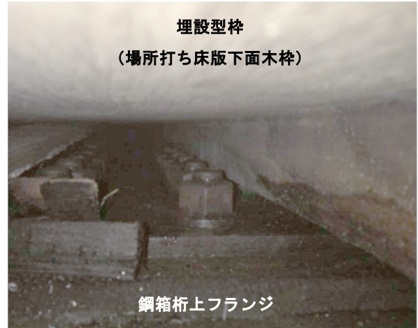
写真-3 鋼箱桁上フランジ (CCD)
