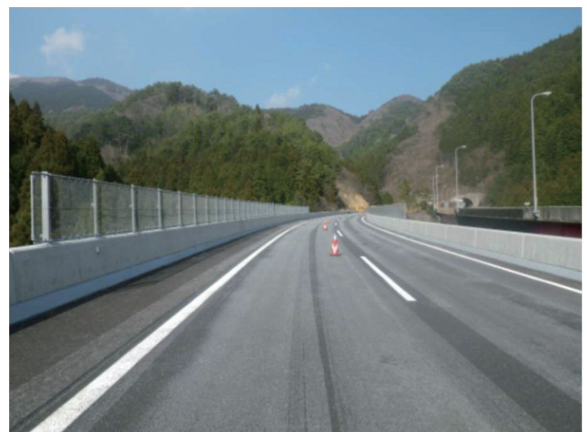
写真-8 常国橋施工後全景
