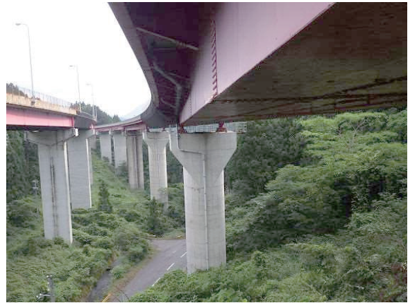
写真-1 常国橋施工前全景
