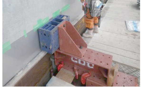
写真-4 サイドブロック
