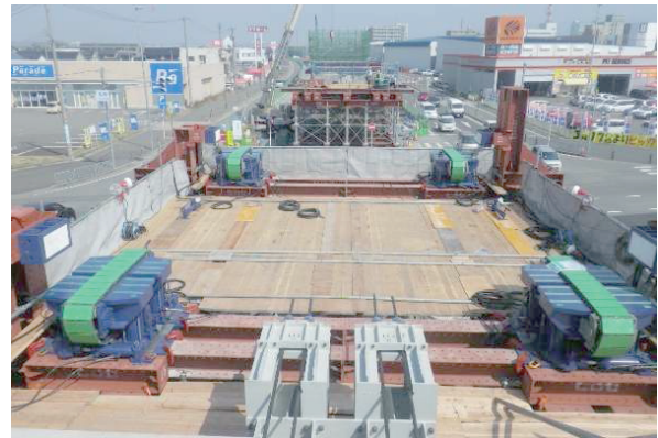
写真-7 仮支柱上のエンドレス送り出し装置
