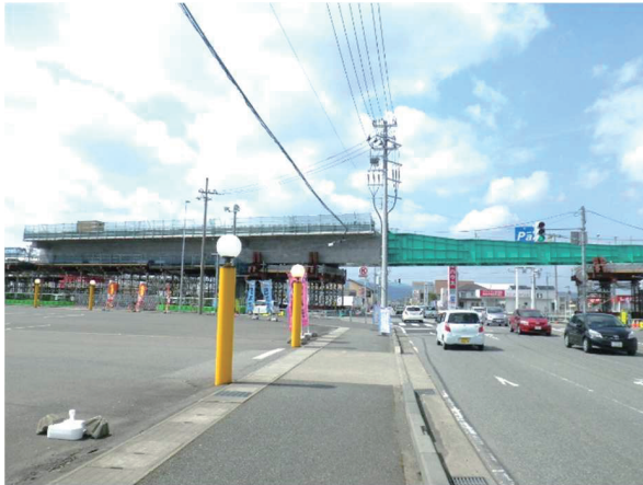
写真-5 押し出し架設1日目全景
