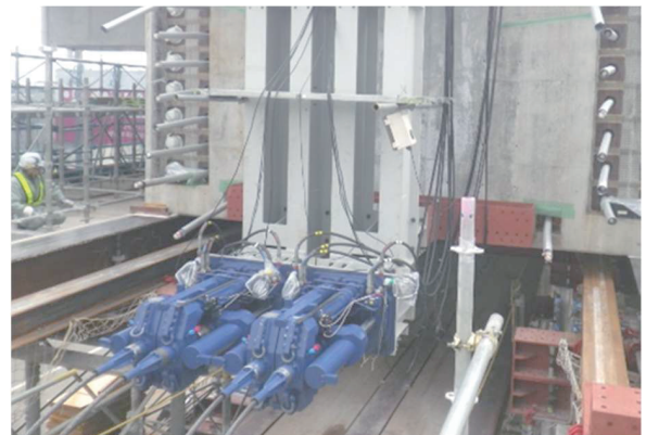
写真-2 ダブルツインジャッキ設置
