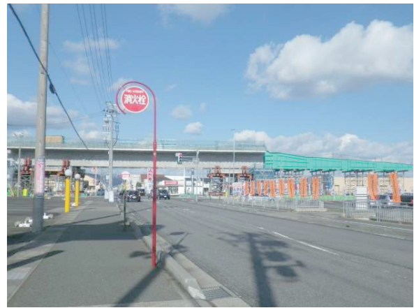
写真-6 押し出し架設2日目全景
