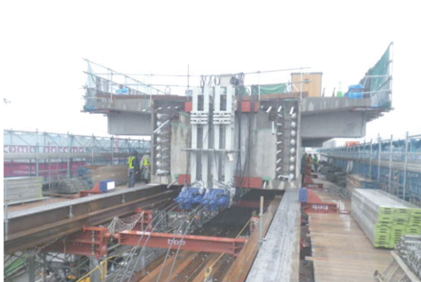
写真-1 押し出し架設状況
