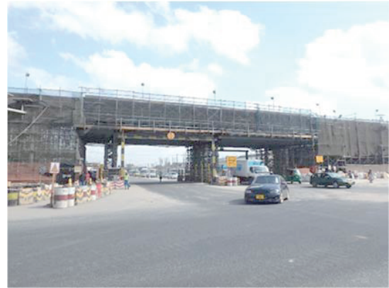
写真-5 交差点部の支保工
