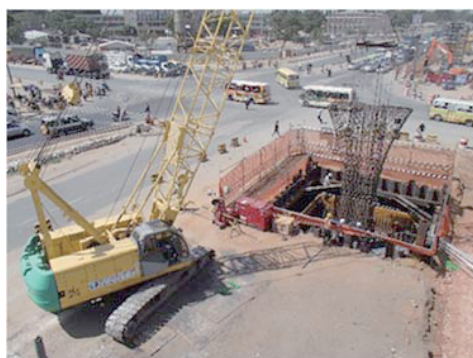
写真-2 鉄筋かご吊り込み状況
