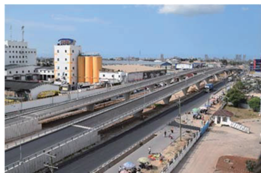
写真-1 ムフガレフライオーバー全景
