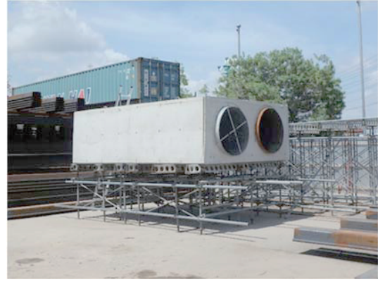
写真-4 実物大打設試験体
