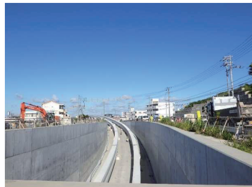
写真-8 地下区間入口の外観
