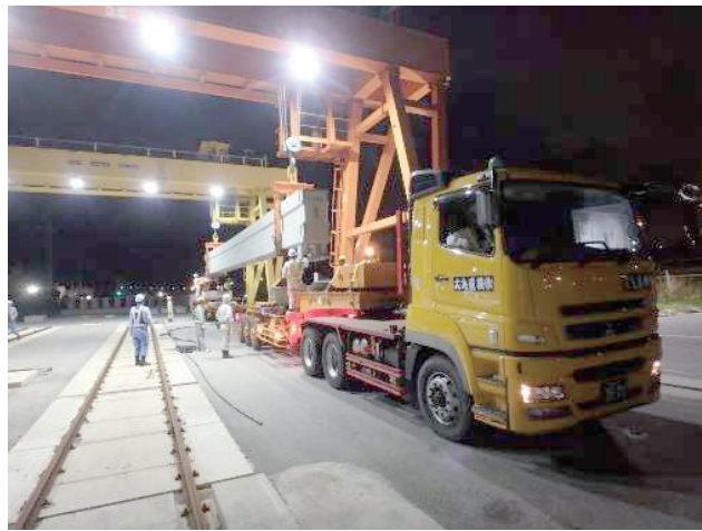
写真-2 PC軌道桁積込状況
