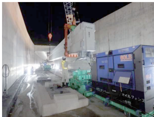
写真-4 PC軌道桁取卸し状況
