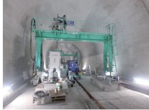
写真-6 PC軌道桁架設状況
