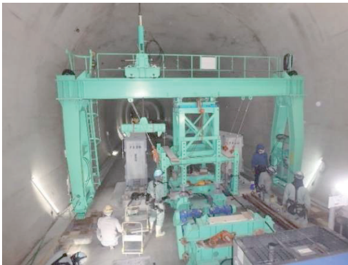
写真-7 門型クレーン移動・セット状況
