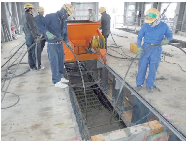
写真-1 コンクリート運搬車による打設状況
