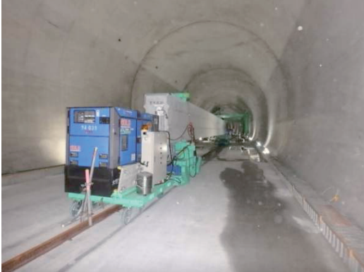
写真-5 PC軌道桁自走台車による運搬状況
