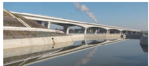
写真-4 菟野第一高架橋
