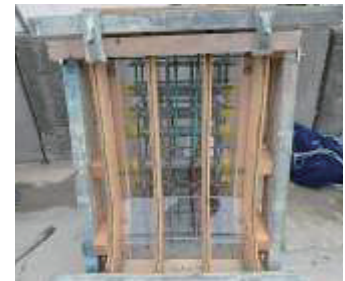
写真-3 供試体透明型枠
