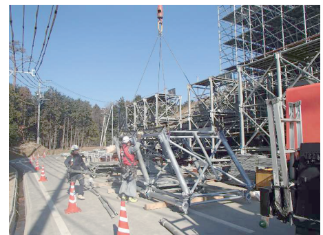
写真-1 ユニット型支保工組立状況
