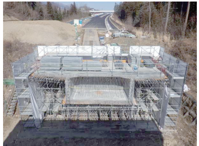
写真-2 先行施工完了
