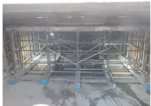
写真-4 内部支保工組立状況
