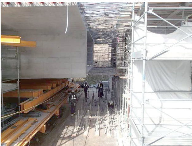
写真-3 支保工組立状況
