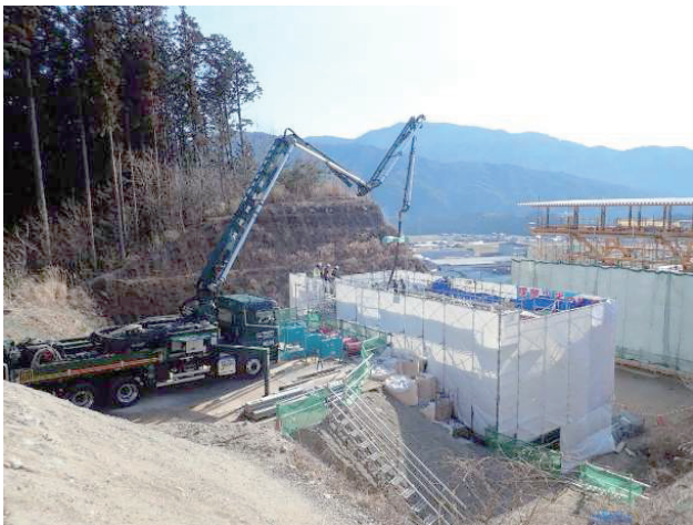
写真-1 先行施工状況
