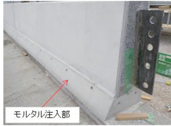
写真-4 モルタル注入部脱型後の状況
