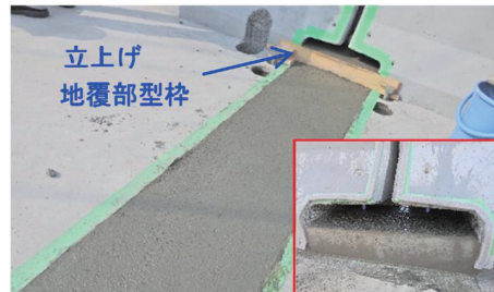
写真-6 間詰め部施工状況
