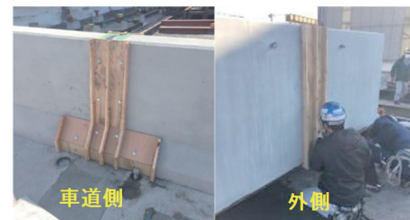
写真-7 目地部型枠設置状況
