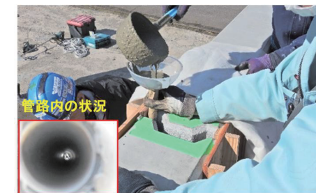
写真-8 目地部モルタル充填状況
