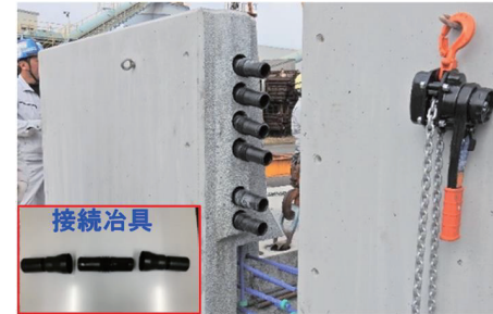
写真-5 管路接続治具設置状況
