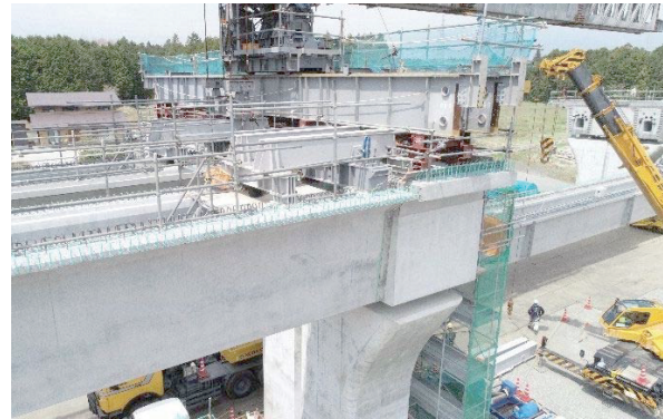
写真-4 ビーム材を用いた架設状況
