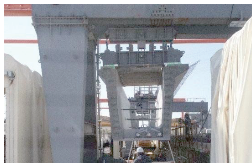
写真-3 プレキャスト桁吊上げ状況
