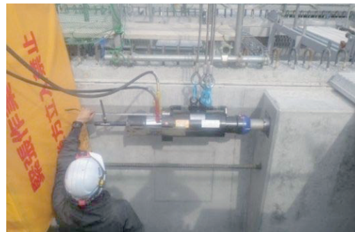
写真-2 1S28.6ECF ストランド緊張状況
