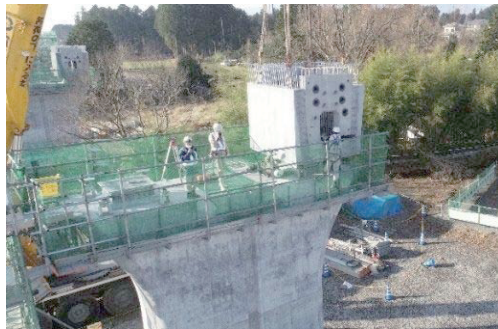
写真-1 柱頭部セグメント架設状況
