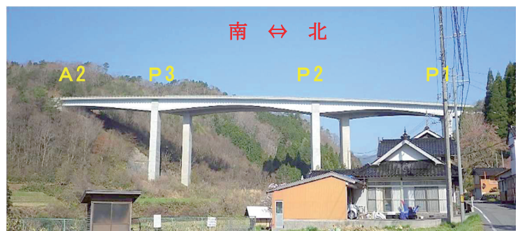
写真-1 橋梁全景（写真手前が上り線）
