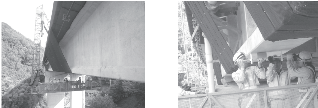
写真-2 大型の橋梁点検車の走行による橋軸方向の着磁状況 (左：橋梁点検車，右：着磁状況)
