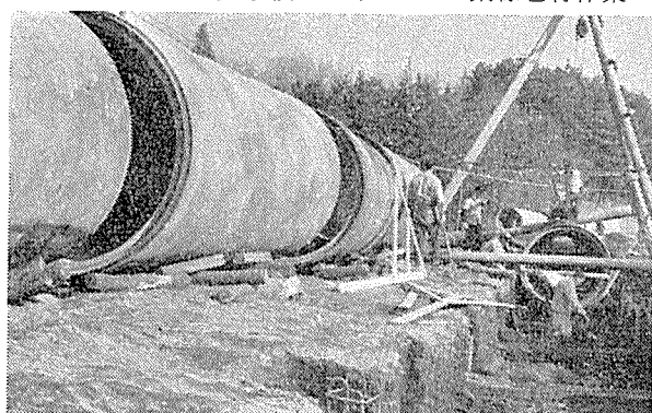
写真-3 PC 管現場敷設作業
