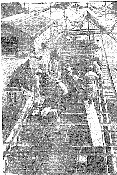
写真-1 コンクリート打ち作業
