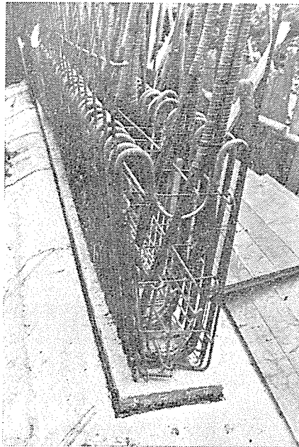
写真-3 メナーゼ ヒンジの施工状況
