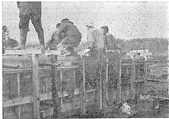
棒状バイブレーターおよび型わくに取りつけた固定バイブレーターによる。つき出ているパイプは横締め用のケーブル孔を作るためのもので、コンクリート打ち後、数時間でぬきとった。
