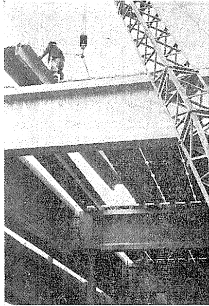
写真-8 大バリ G_1 と小バリ B の接続 (ダブルTスラブしき渡し間)
