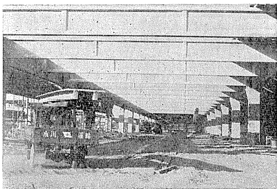
写真-12 各 PC バリの架設された現場への ダブル T スラブの搬入
