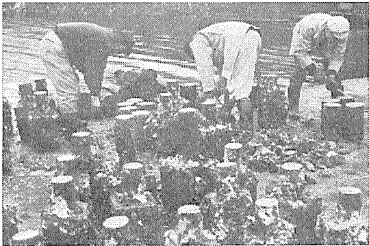
写真-2 引き上げられたテストピース
