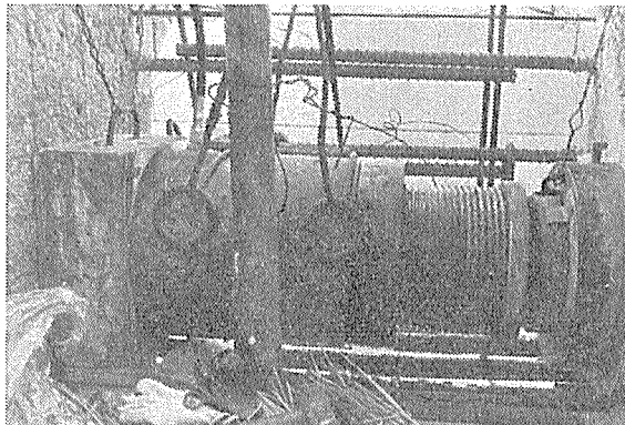
写真-11 同 左 クラウンに装置した応力調整用ジャッキ (300 t 油圧式)
