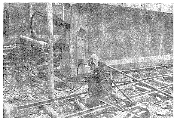
写真-7 同 上 フレシネ ジャッキ装置
