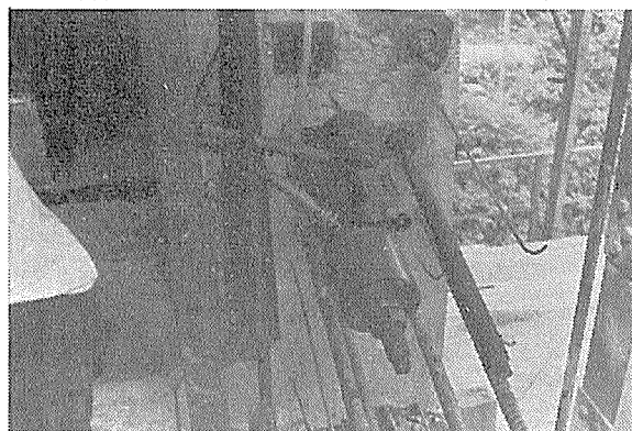
写真-4 同上 片持ばりの先端のティビダーク ジャッキ装置
