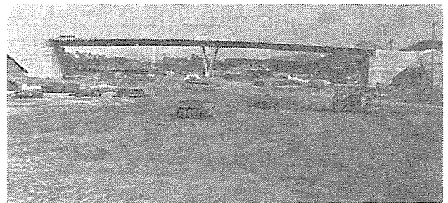
ほぼ完成した岡本跨高速道路橋
