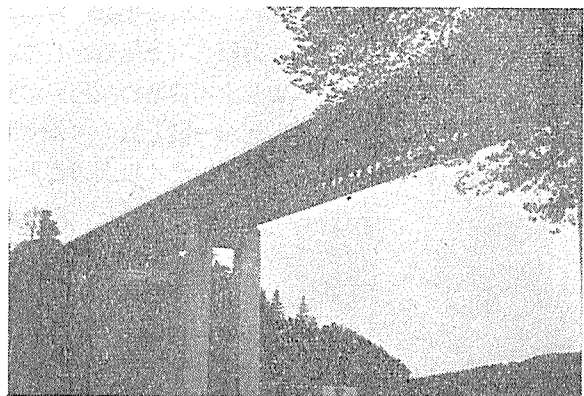
写真-12 新 Manefallbrück の PC トラス (西ドイツ)
