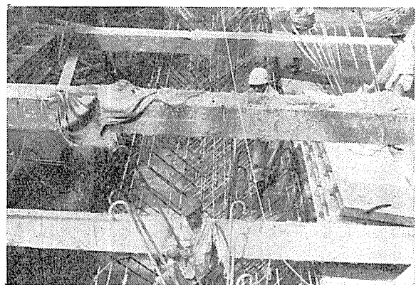
写真-7 ヒンジ部施工状況
