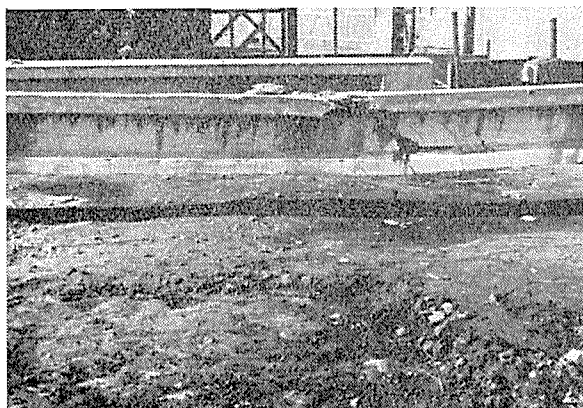
写真-11 K 66 桁の破壊状況
