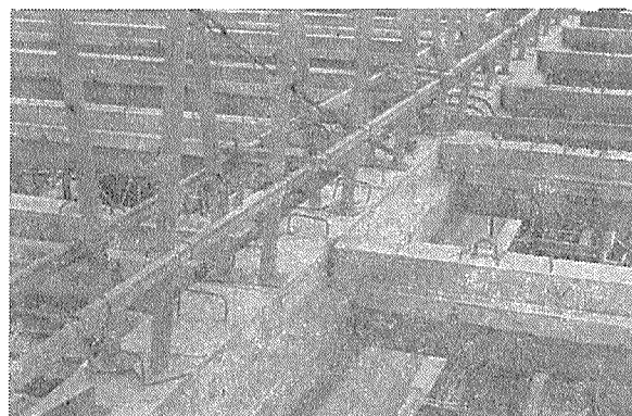
写真-9 スラブ筋完了
