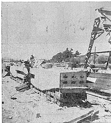
写真-6 工場製作された枕ばり
