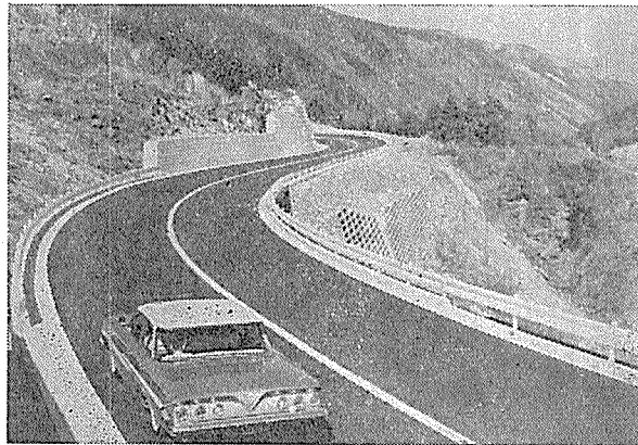
写真-2 二子棧道付近の道路線形クロソイド反向曲線
