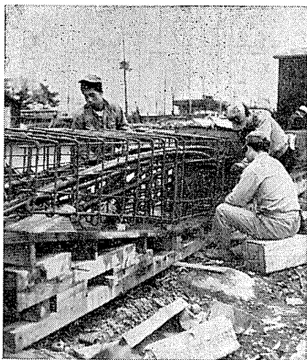
写真-5 (b) 工場における脚柱ブロックの鉄筋, PC鋼材, 型わく組立作業 (下側より見る)
