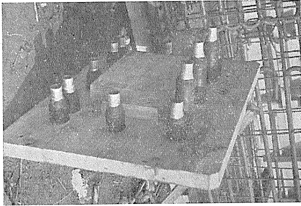
写真-6 工場製作された枕ばり
