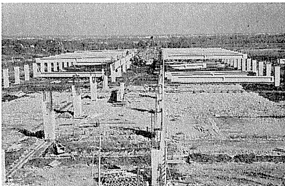
写真-1 工場棟全景 (柱は現場打 RC)
