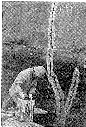
写真-2 接着剤(3003 J)を塗布した上にモルタルを入れ大クラックの補修を行なっている状況
