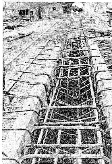
写真-3 主桁の配筋 (12 m 桁端部)
