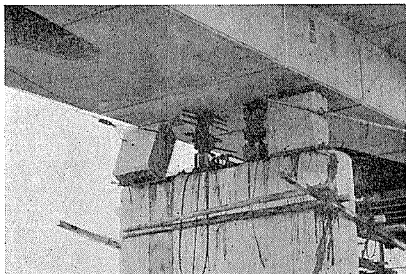
写真-9 コンクリート ロッカーそう入 (中央は 200t ジャッキ2台)
