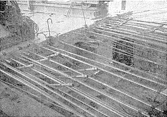
写真-13 同じく吊鋼棒定着側アンカー（両主桁で18本）
