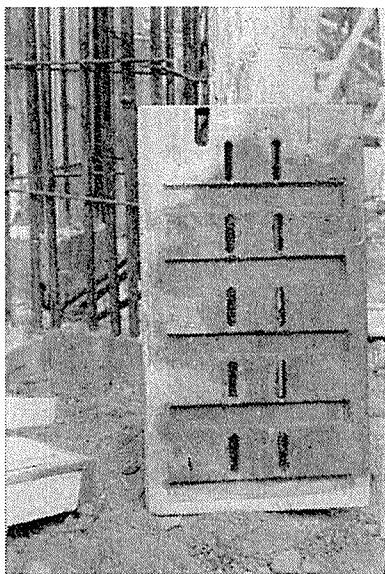
写真一 打継目部隔板
