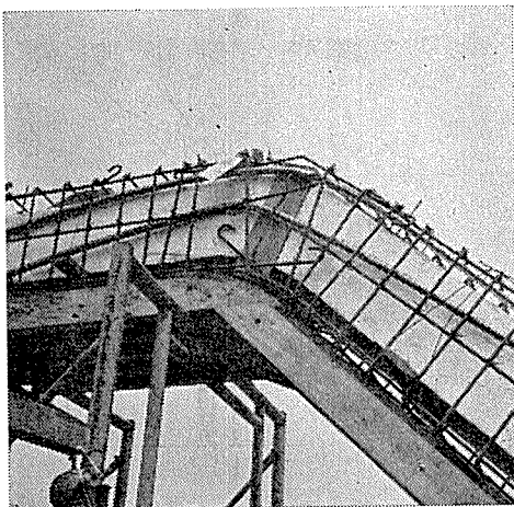
写真-1 隅角部配筋ならびに内部型わく発泡スチロール
