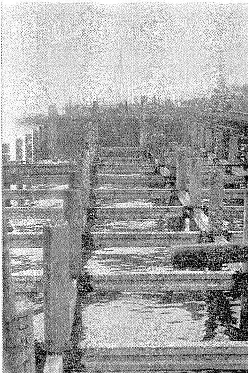
写真-3 パイルと継り
