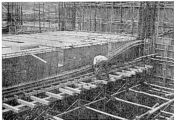
写真-3 PC大ばり端部の配筋詳細
