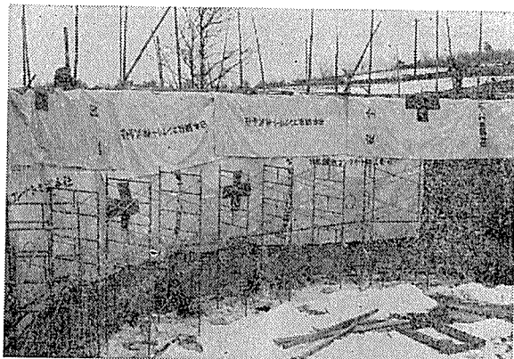
写真-6 コンクリートの養生状況
