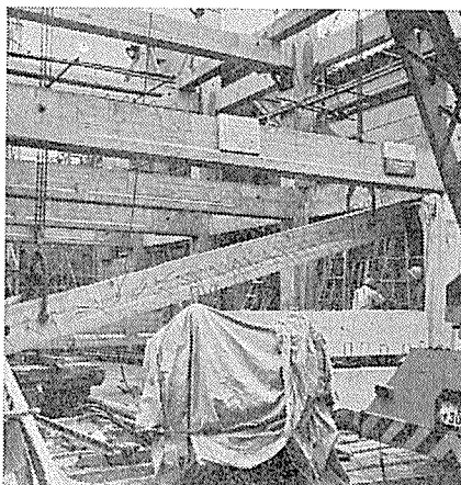
写真-9 大ばりを1階から吊上げた所
