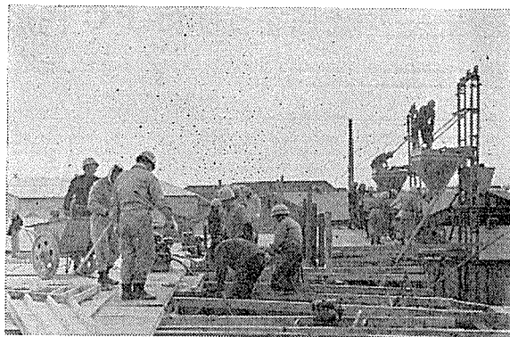
写真-9 上床版のコンクリート打込み作業
