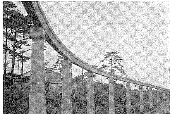
写真—6 架設完了のモノレール桁
