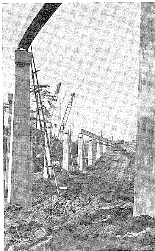
写真-1 架設中のモノレール桁
