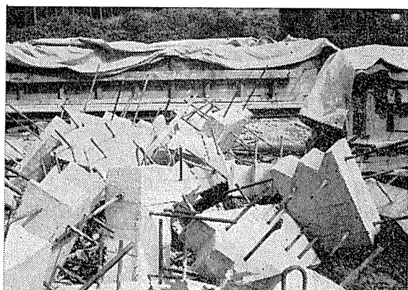
写真-3 内型わく固定用コンクリートブロック
