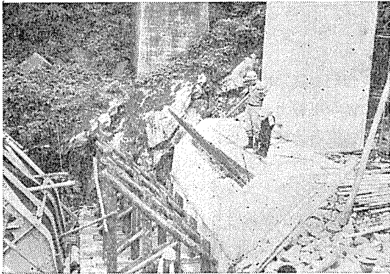
写真-2 ヒンジ部コンクリートの切欠き部
